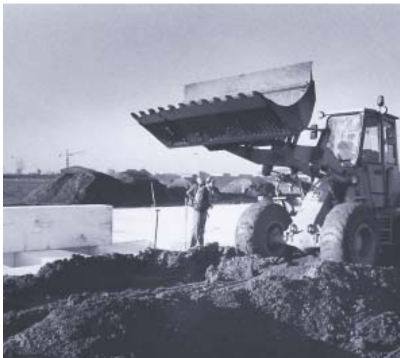
Renovatie S110, Wijchen.
