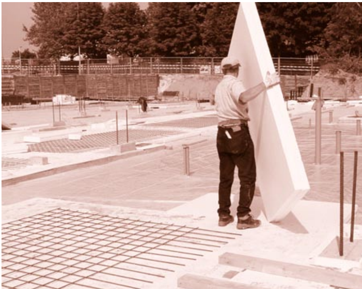
Plaatsing EPS-T onder industrievloeren.
