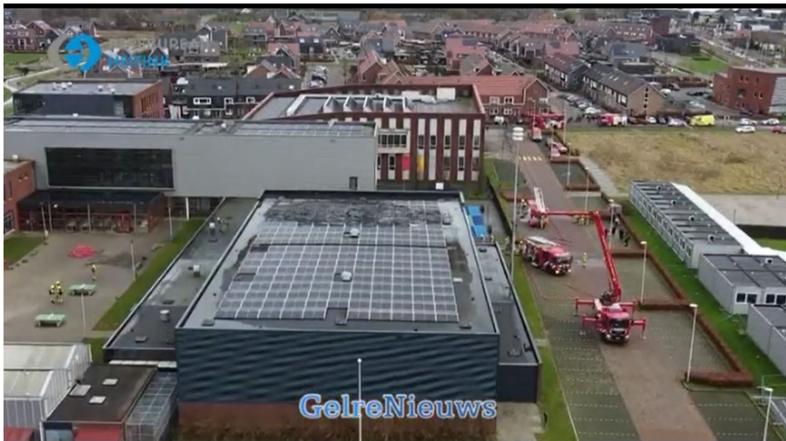
Abbildung 18 80% des Daches sind mit Solarzellen bedeckt (Quelle: GelreNieuws)
