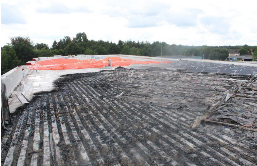
Abbildung 4 Das Feuer wurde vor der Brandtrennung gestoppt (an der Stelle der Plane auf dem Dach) (Quelle: Feuerwehr Twente)
