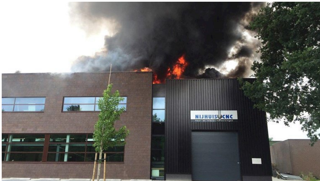
Abbildung 1 Feuer auf dem Dach (Quelle: www.rtvooost.nl )
