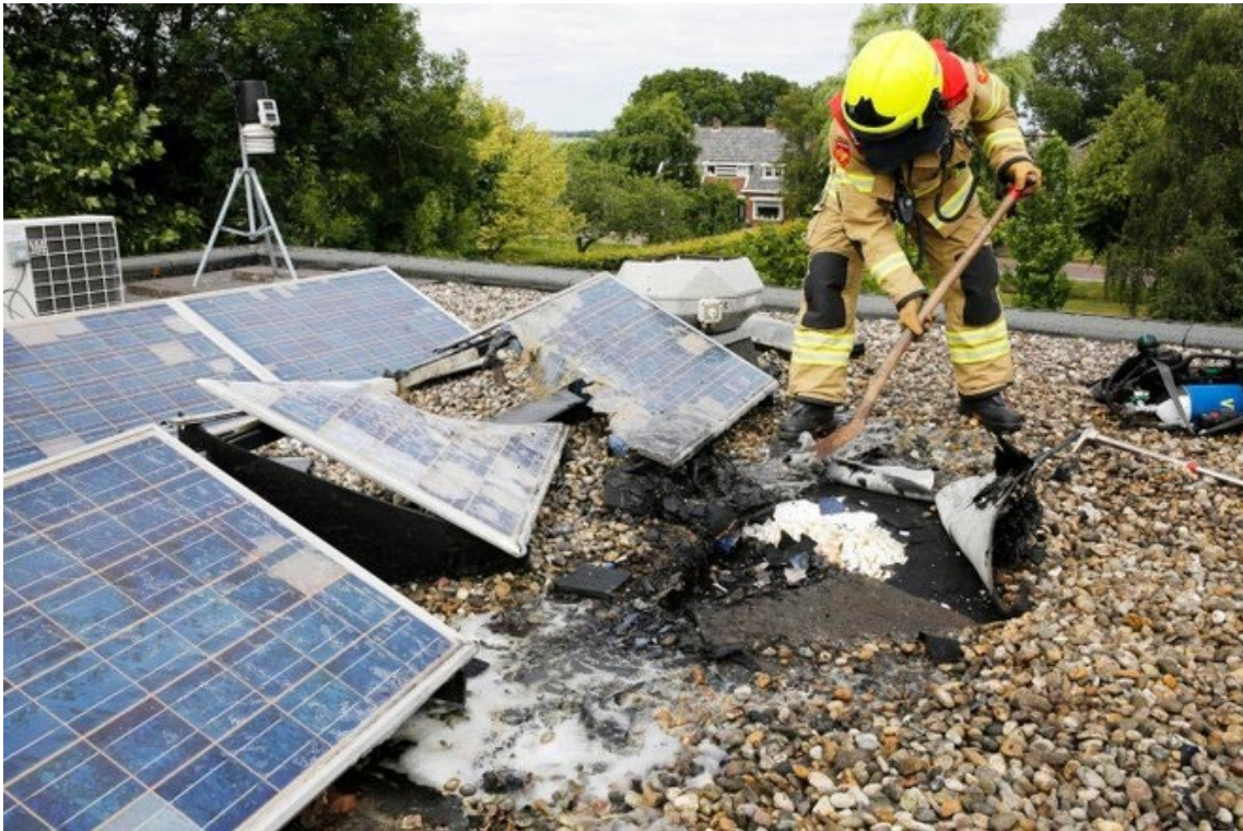
Abbildung 7 Feuer auf dem Dach des Rathauses von Opmeer (Quelle: www.noordhollandsdagblad.nl )
